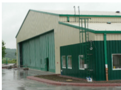
Budowa lądowiska dla śmigłowców w m. Hawniki (Bieszczadzki Oddział Straży Granicznej)
