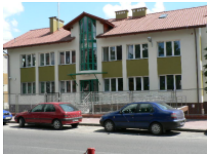
Rozbudowa strażnicy SG w m. Lubaczów (Bieszczadzki Oddział Straży Granicznej)
