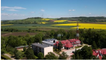
siedziba zmodernizowanej Placówki SG w Hermanowicach
