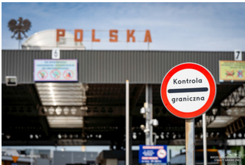
Znak Kontrola Graniczna w przejście drogowe
