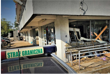
Patrol pilnuje opuszczony sklep
