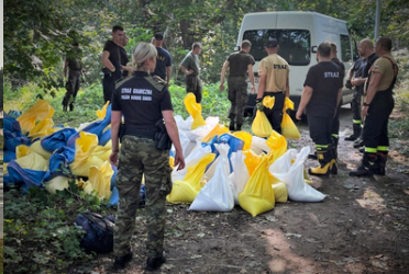
Umacnianie wałów przeciwpowodziowych
