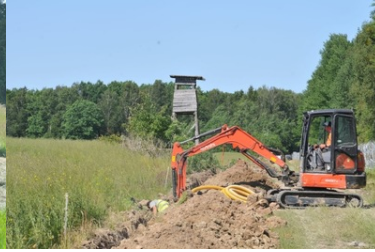
Trwa instalacja bariery elektronicznej na granicy z Rosją
