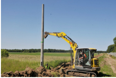
Instalacja bariery elektronicznej na granicy z Rosją
